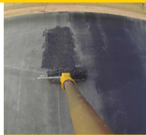
AANBRENGEN VAN DE LIJM
